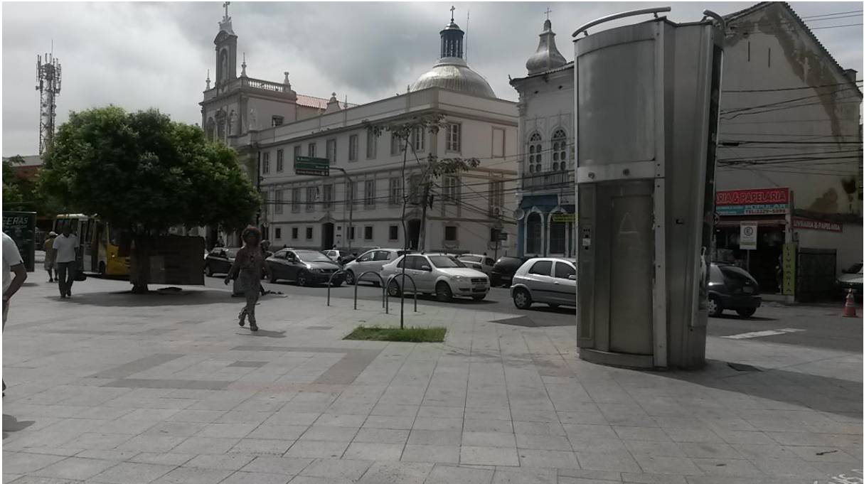
Figura 14: Estrutura de banheiro público, sem funcionamento, na Praça da Piedade.
